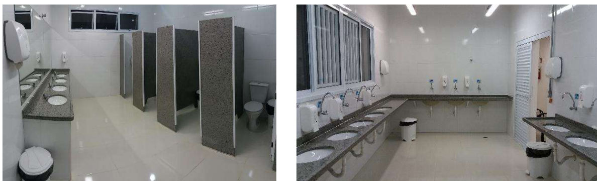
Figura 17 - Sanitários e Barreira Sanitária
